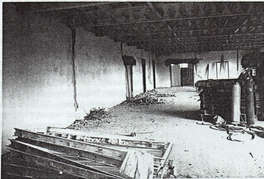
Tak obecnie wygląda przyszła aula
